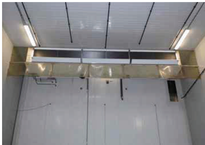
De hoogefficiënte luchtkoeler in de koelcel bij WFO in Zwaagdijk-Oost.
