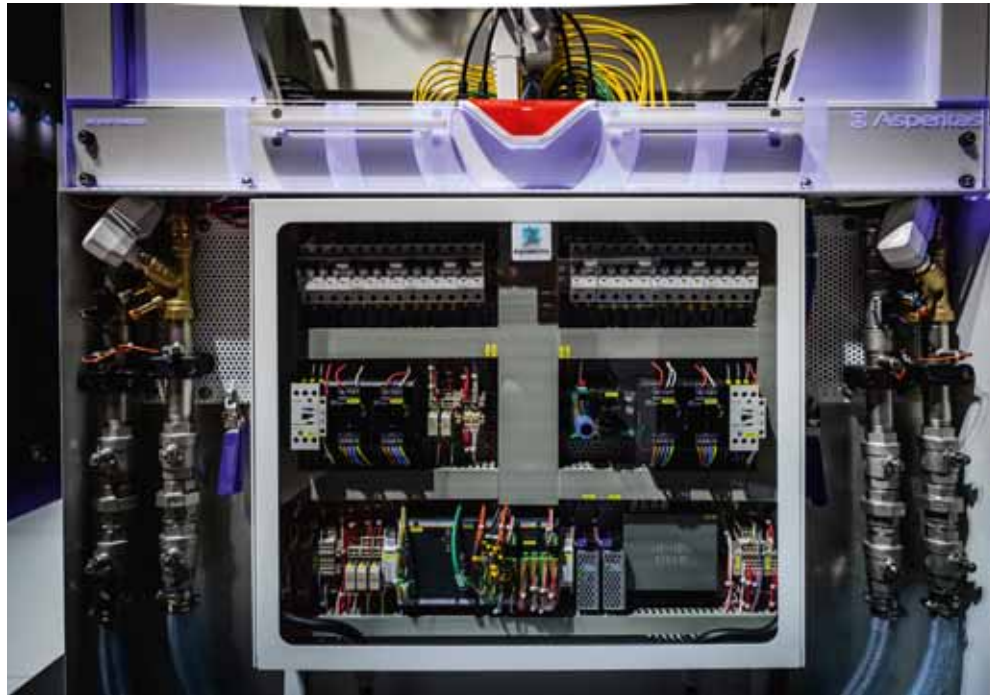
De binnenkant van de unit, met links en rechts de aansluitingen voor het koelwater.
